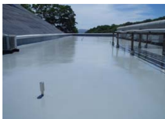
防水工事 完了
