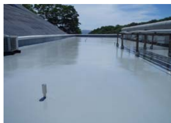
防水工事 完了
