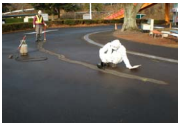
クラック補修 充填状況
