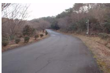
舗装工事 着手前
