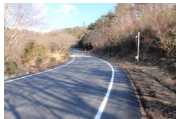
舗装工事 完成
