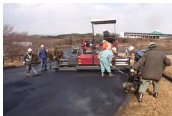
舗装工事 薄層工施工
