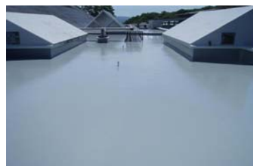
防水工事 完了
