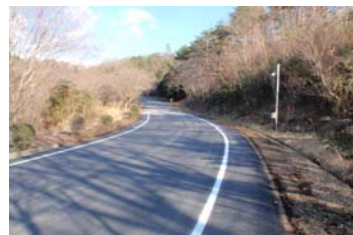
舗装工事 完成
