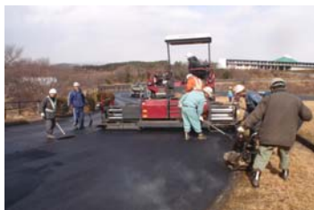
舗装工事 薄層工施工
