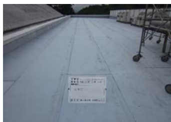
陸屋根部の防水工事 着手前
