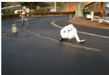
クラック補修 充填状況
