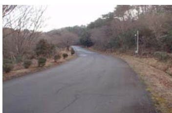
舗装工事 着手前
