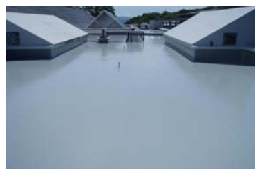
防水工事 完了
