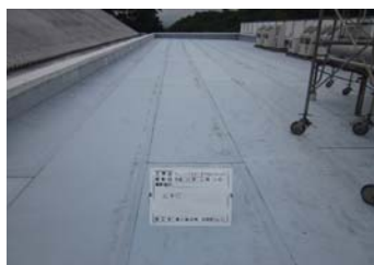
陸屋根部の防水工事 着手前
