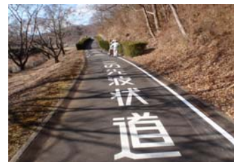
区画線工 施工
