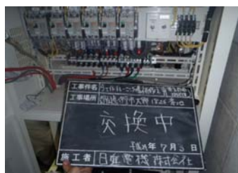
整流器交換・配線接続
