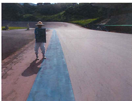
着工前 ホーム
