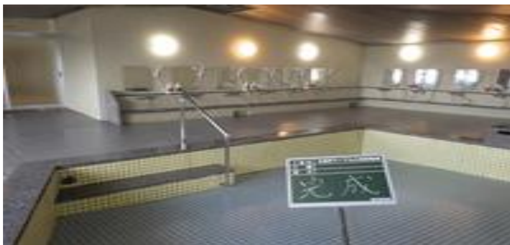
(完成写真 ④浴室)
