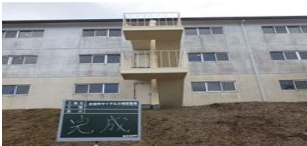
(完成写真 ⑤非常階段)
