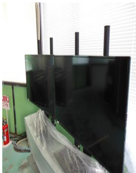
遠方監視装置（監視塔機器） ②
