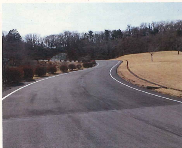
走路補修施工（完成）
