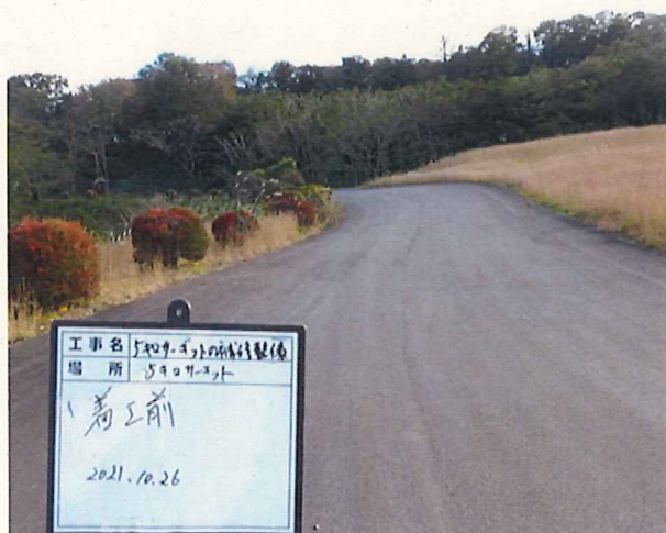
走路補修施工（着工前）
